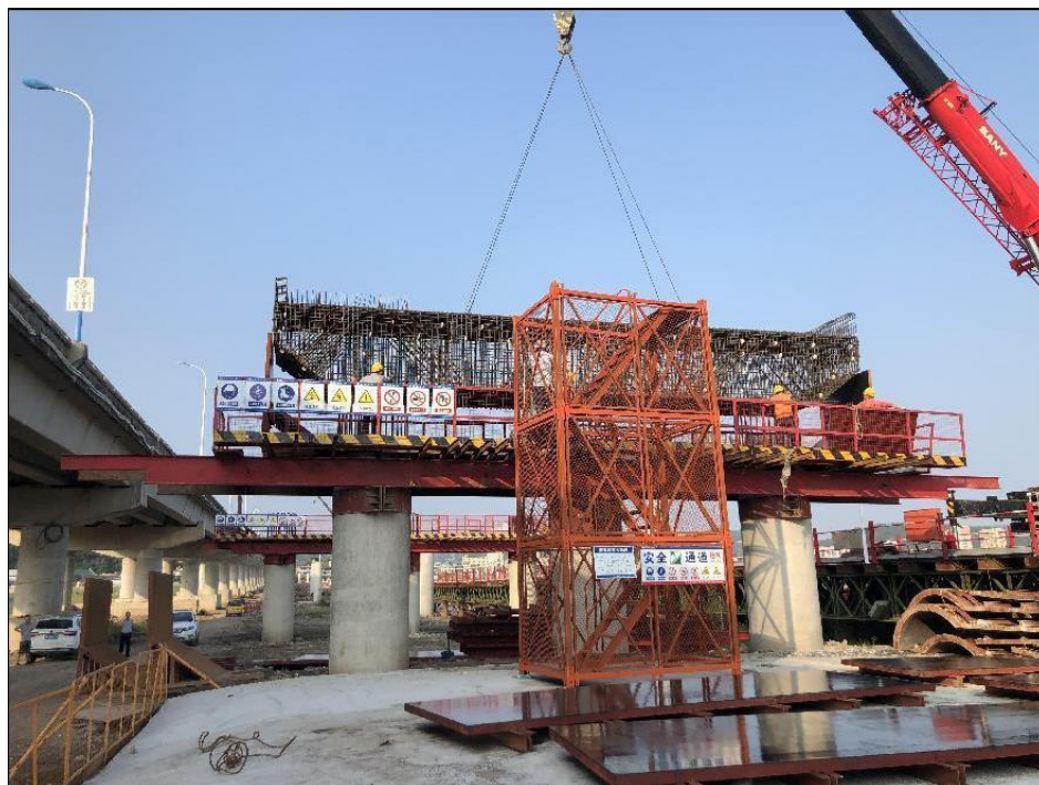
图 3.4-2 柱式盖梁现场吊装现场图
