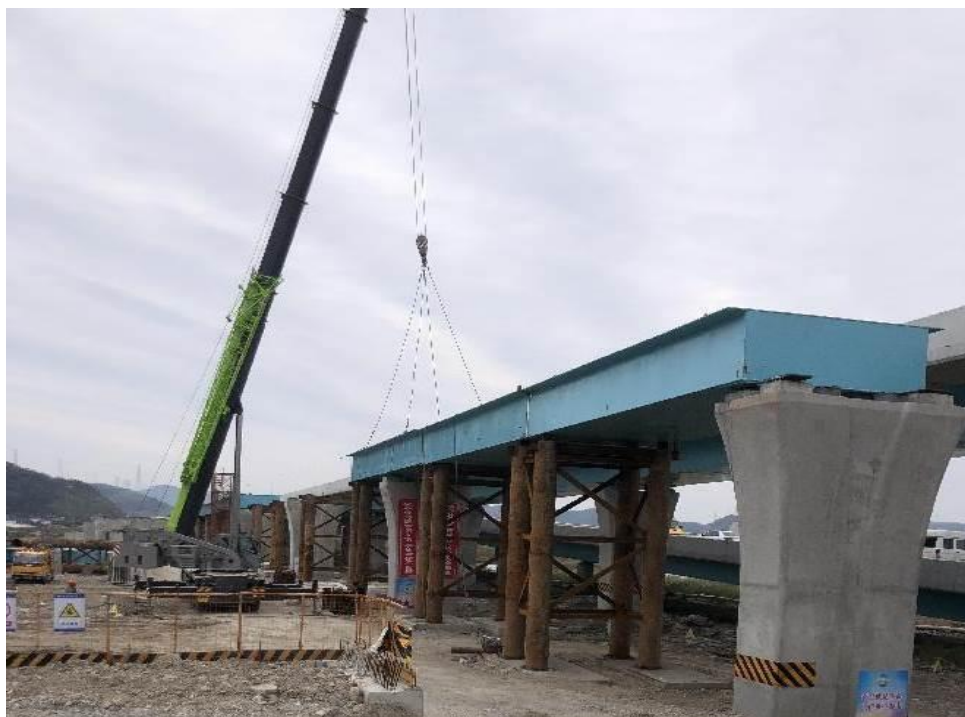
图 3.4-7 钢梁安装现场图
