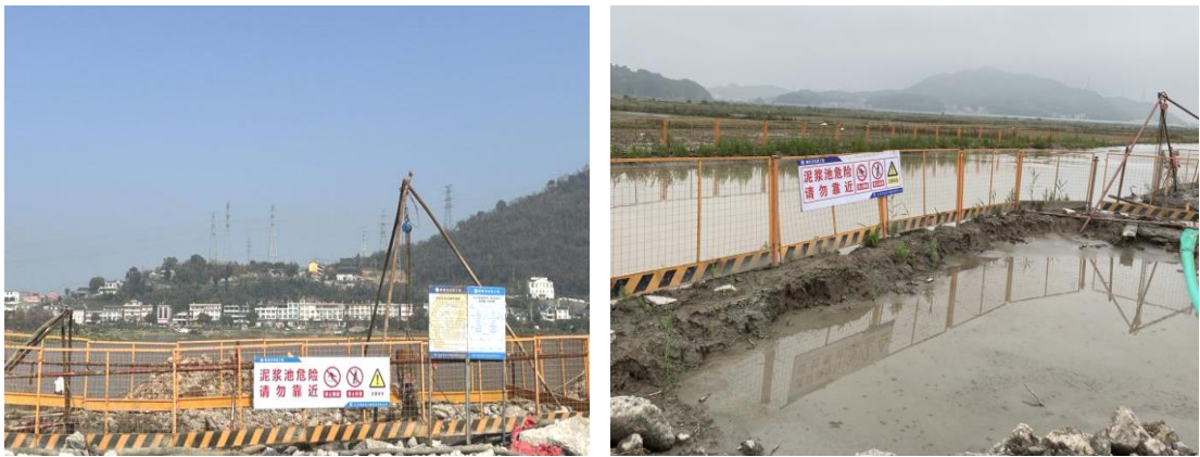
图 5.1-2 施工现场泥浆池照片
