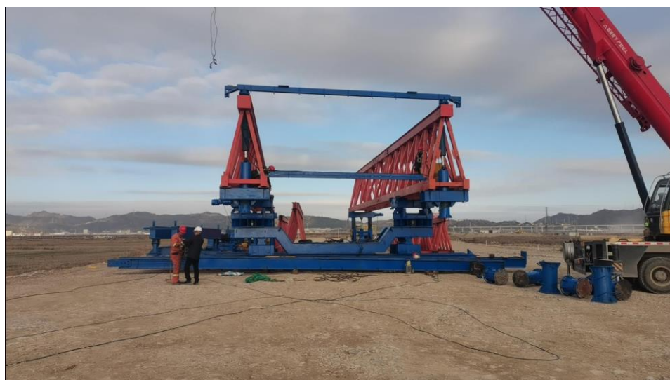
图 3.4-4 260t 架桥机拼装现场图
