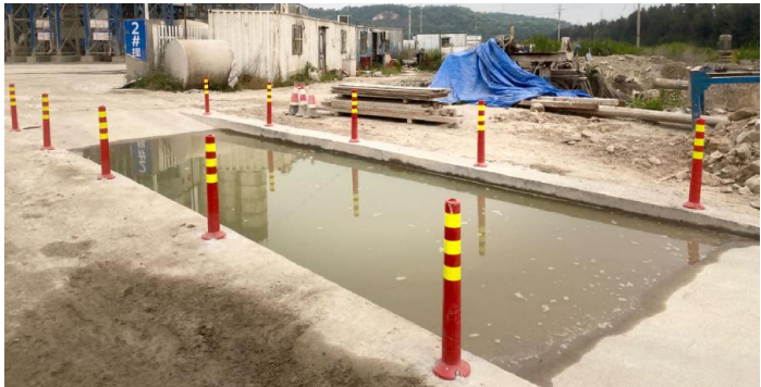
图 5.1-3 综合施工场地车辆冲洗池
