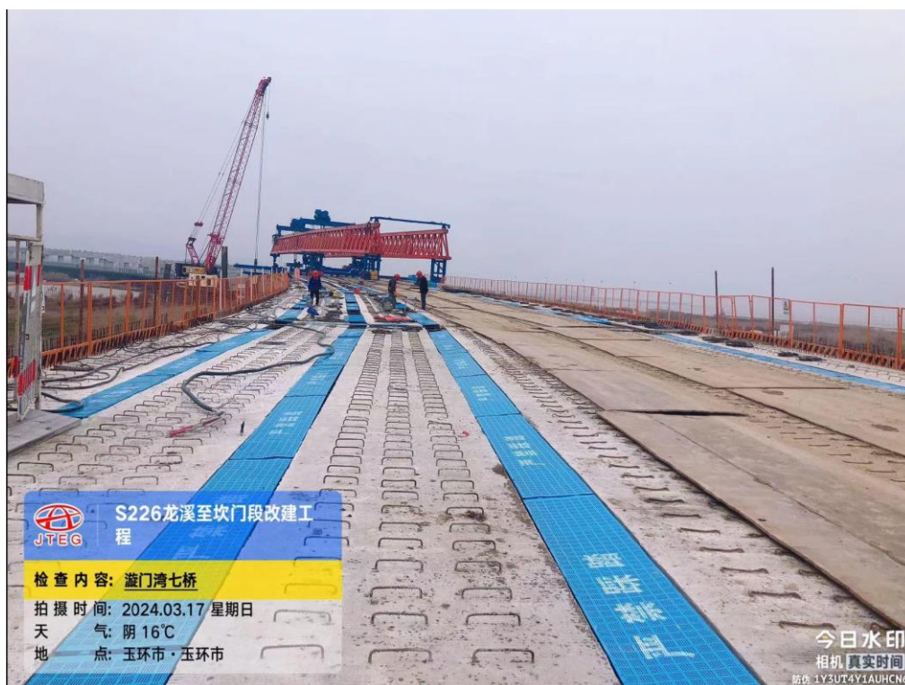
图 3.4-6 T 梁安装现场图
